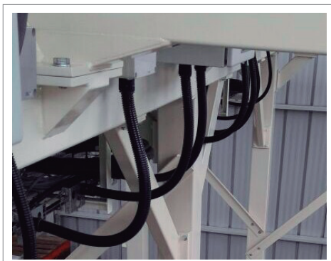
Tubería de Poliamida y Bandejas "Viafil" de Acero Inoxidable - Callao
