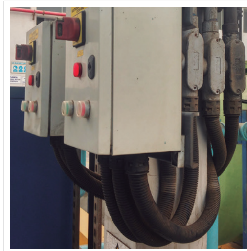
Tubería de Poliamida en Industria Química - Lurín
