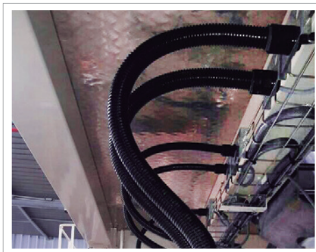
Tubería de Poliamida y Bandejas "Viafil" de Acero Inoxidable - Callao
